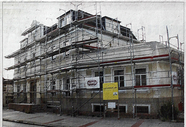
Nur mit einem neuen Farbenstrich von außen war es nicht getan. Auch im Gebäude wurde umfangreich saniert. (Foto: Schramm, privat)
