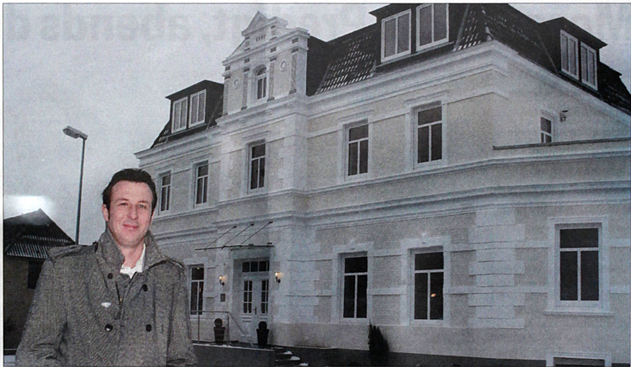
Aus dem Hotel „Zur Post“ wurde das Hotel „Kleiner Yachthafen“: Hans Helmut Schramm vor dem sanierten Gebäude.
